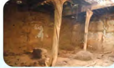
مسجد تاريخي قبل ترميمه
