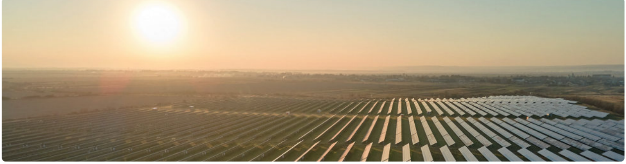
شكل 1.9: الطاقة الكهربائية النظيفة من الألواح الكهروضوئية الشمسية
