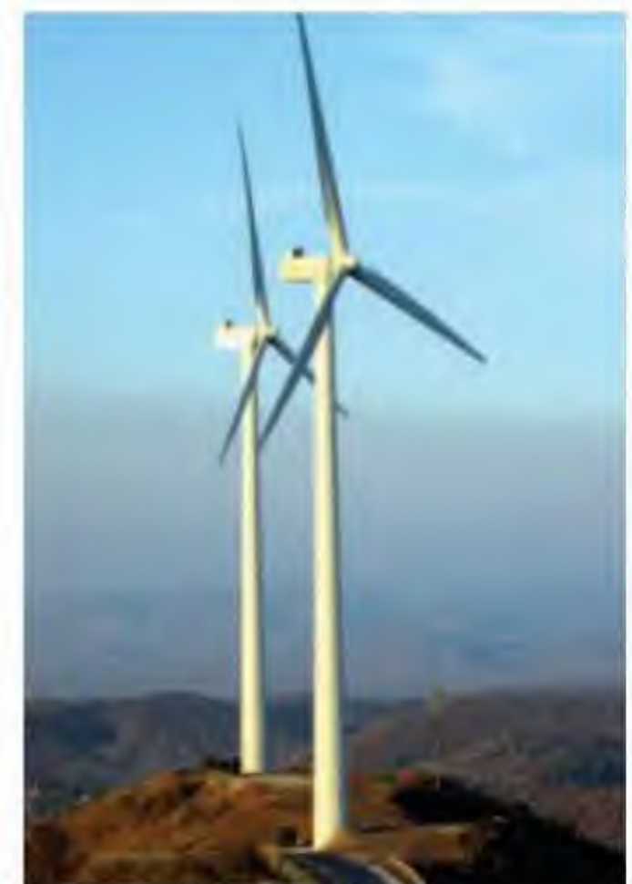
الشكل ٦ تعمل مراوح الهواء بنفس مبدأ منشآت الطاقة، وبدلاً من إدارة المحرك البخار يُدار بالمراوح التي تحركها الرياح. صف بعض مزايا وسلبيات استعمال مراوح الهواء.
