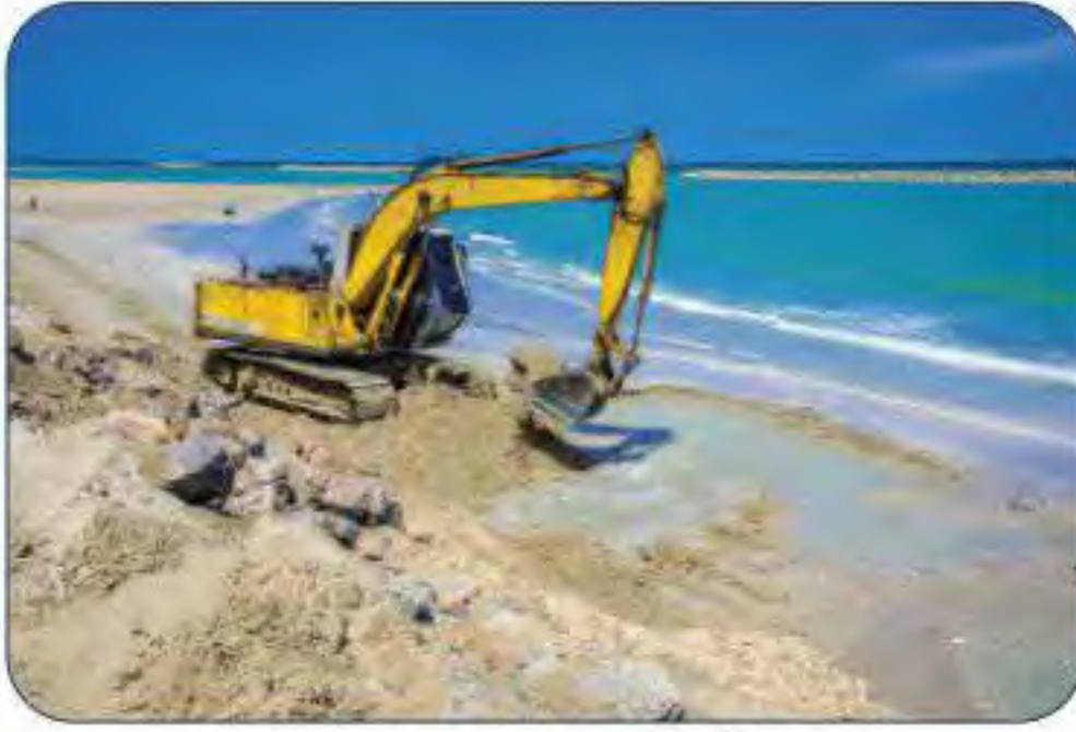
شكل 24-8 تجريف مياه البحر.
