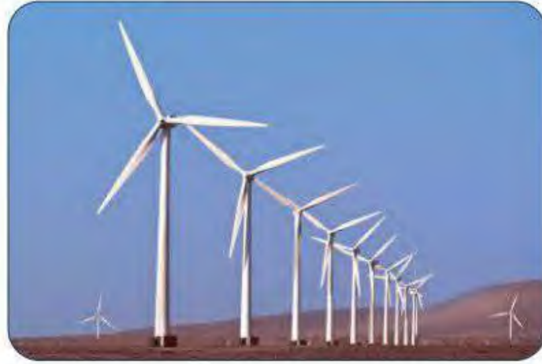
شكل 7-19 توليد الكهرباء باستخدام طاقة الرياح
