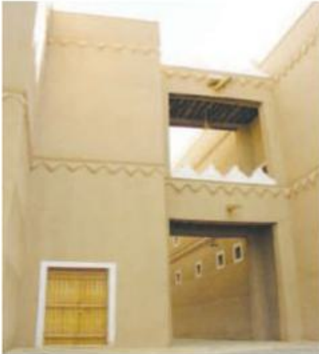
الشكل (٢) البيوت الشعبية في منطقة المربع بالرياض
