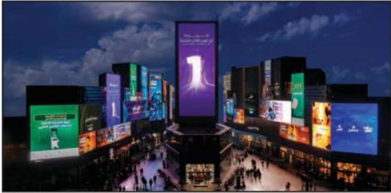
الشكل (٥٧): بعض الإعلانات على أسطح المباني.
