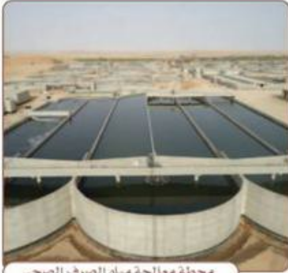
محطة معالجة مياه الصرف الصحي
