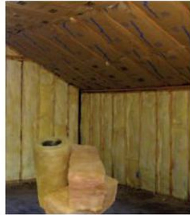
الشكل ٧ تعمل المواد العازلة في المساكن والبنائيات على التقليل من انتقال الطاقة الحرارية بين الهواء داخل المنزل والهواء خارجه.
